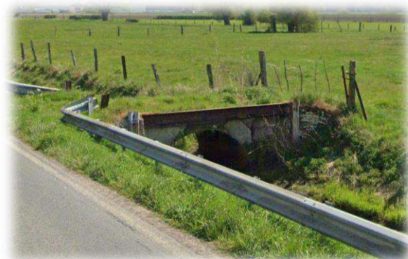
Figure 17 : Pont agricole aval
